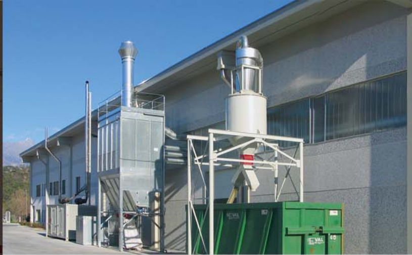
▲ Impianto di trasporto della plastica con relativo stoccaggio e filtrazione dell'aria
